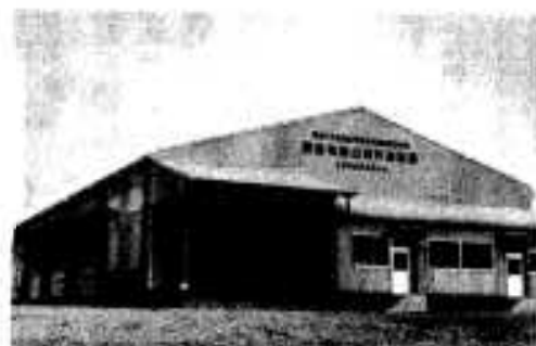
完成したキウイ予冷庫
