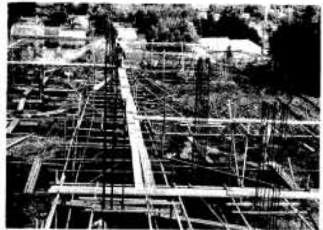
来春の完成を目標に工事が進む現場
