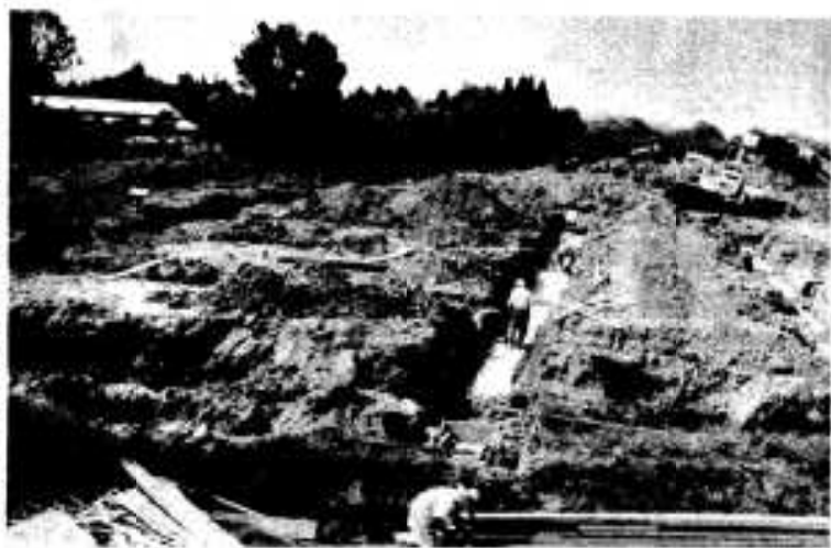
基礎工事が始まり建設が進む
