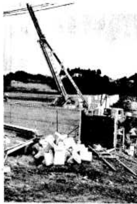
橋脚も完成した新田の現場
