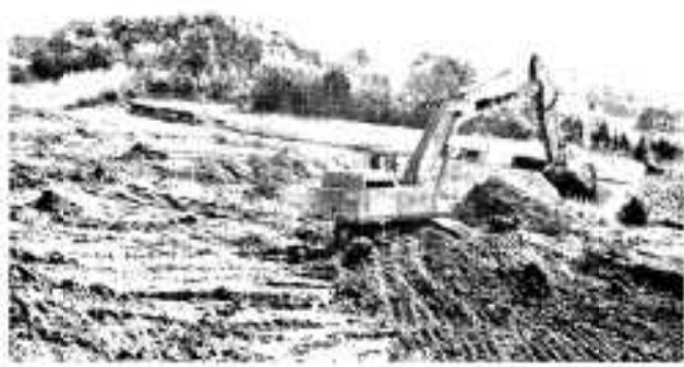
造成が始まった、ジャパン物産工場予定地
