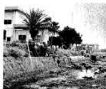
鶴見川の改修も進む
