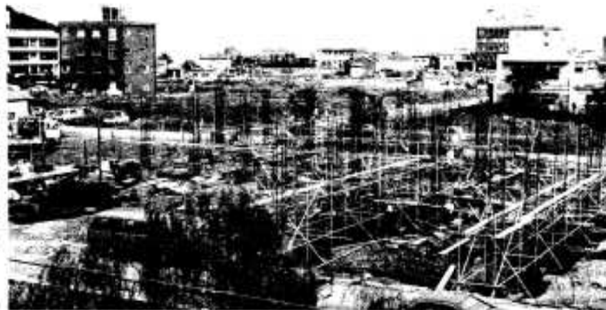
基礎工事が進む保健センター・働く婦人の家の工事現場
