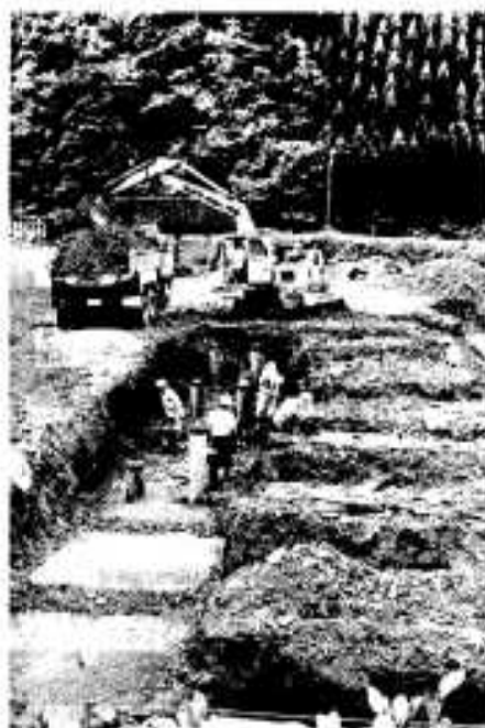
基礎工事が始まった現場
