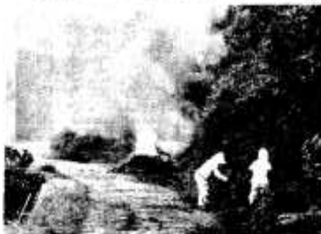
工事が始まった山下弓木野線
