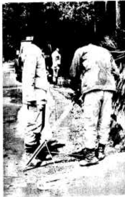
調査が始まった鶴川内地区
