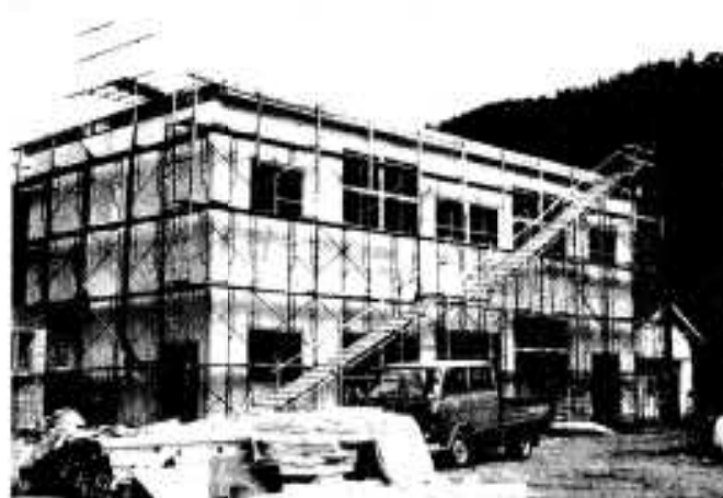
完成間近の隼人中校舎
