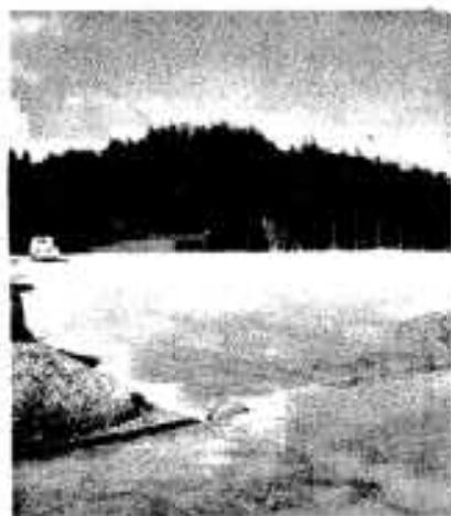
完成した弓木野運動広場
