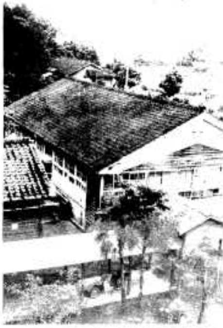
改築される鶴川内中学校の危険校舎
