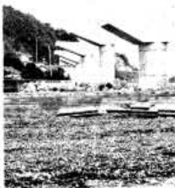
巨大な橋脚が立ち並ぶバイパス工事現場
