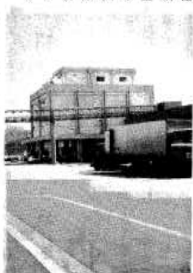
完成した鉄筋三階建ての製氷工場
