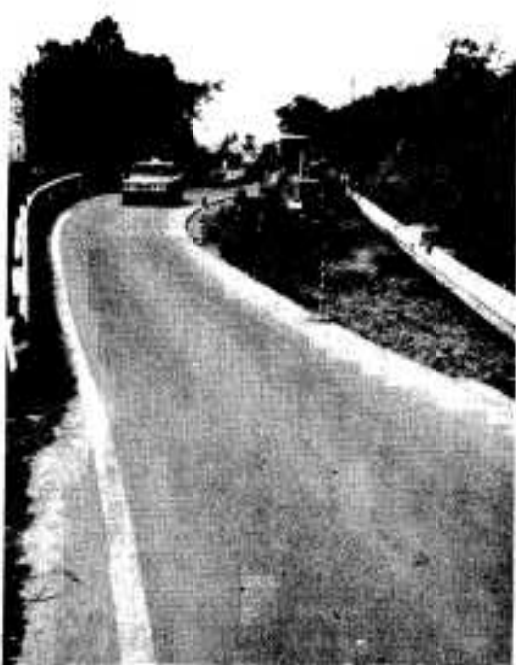
幅員を7mに拡幅（根比）
