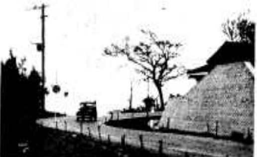
急カーブも幅員を7mに拡幅（浦）
