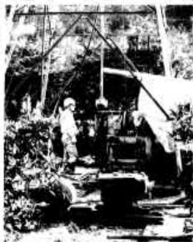
水源地調査のボーリング工事
