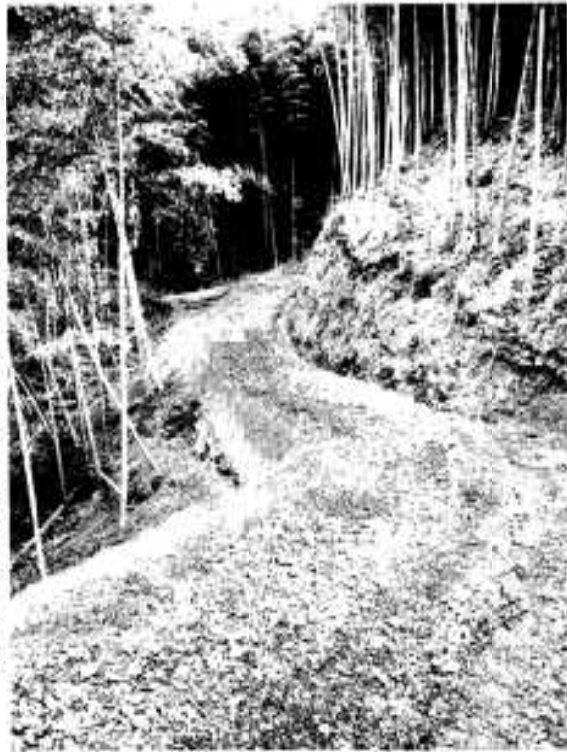
尾崎の狩集線など竹林作業道新設十線に補助
