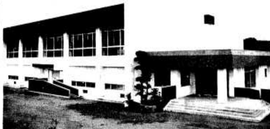
完成した勤労者体育センター
