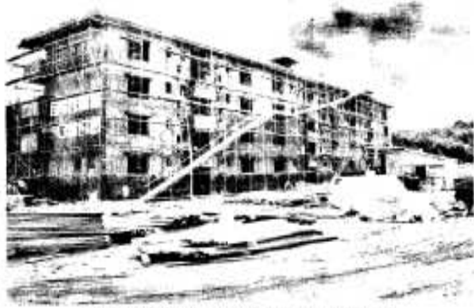
工事が進む県営住宅山下団地
