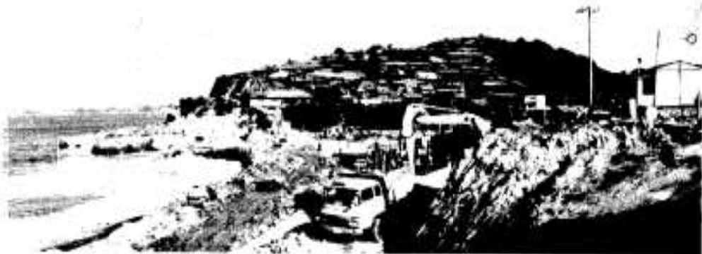
工事が始まった大川橋
