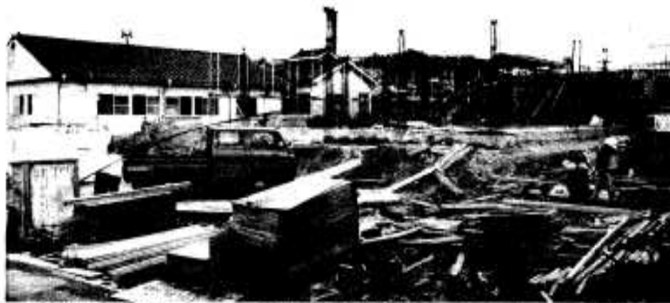
50年に鉄筋二階建ての北病棟が完成して以来、毎年整備
