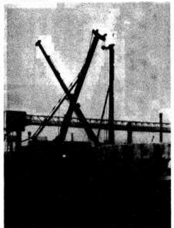
クイ打ち作業が始まる製氷工場予定地
