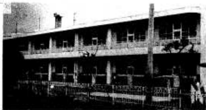
五十年年度完成した鉄筋 二階建ての北病棟百床
