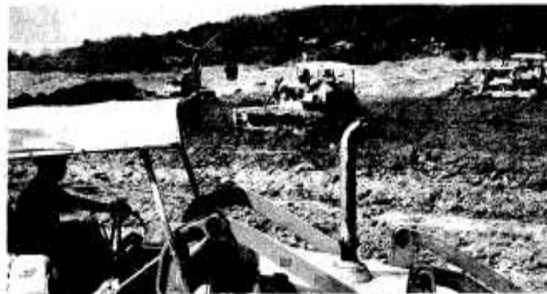
は場整備の始まった鶴川内地区
