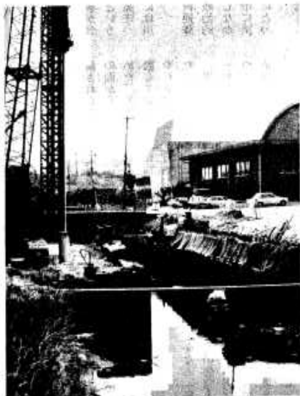
鶴見川の1号橋新設工事で都市計画も本格的な工事へスタート
