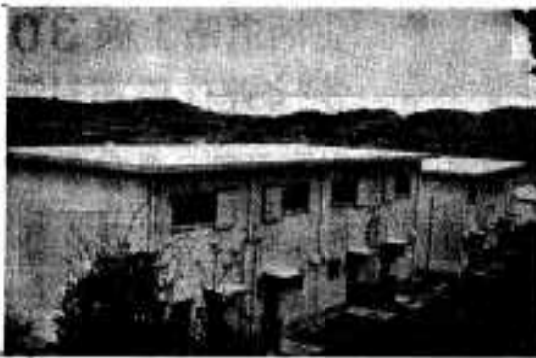
完成した春畑市営住宅
