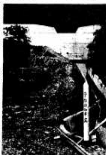
浮迫にえんていが完成
