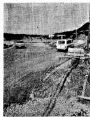
右側道路が現在の中央線 左側が新設される道路
