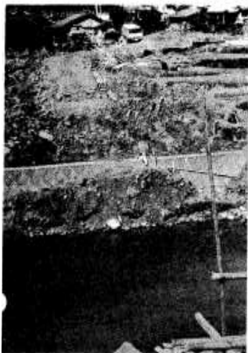
中屋敷橋の取付道路新設も進む
