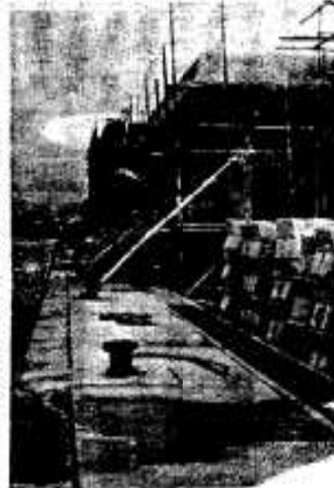
卸売場建設中
