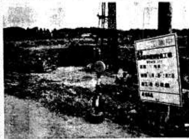
平田橋の架け換え工事始まる
