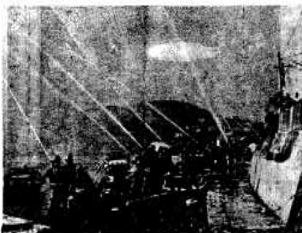
高松川河畔で一斉に放水
