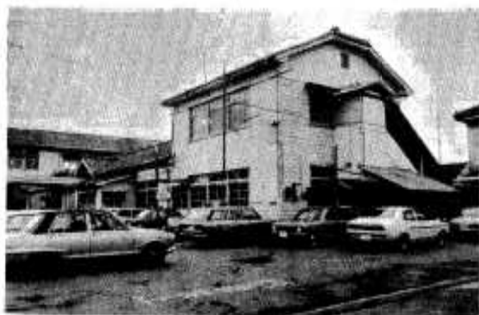
市庁舎建設も夏には着工
