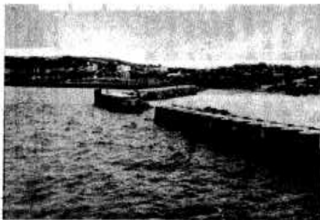
新港理め立ても3月には完了
