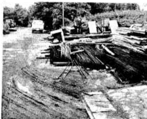
多い道路の不法占用
