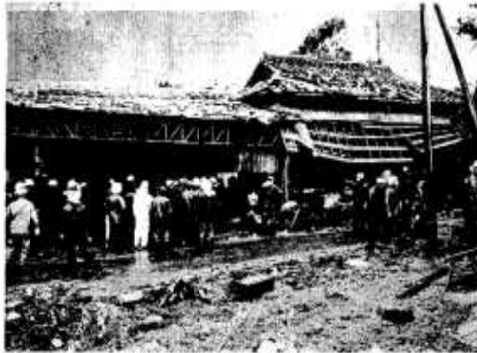
屋根かわらは飛び鉄骨の倉庫も損壊
