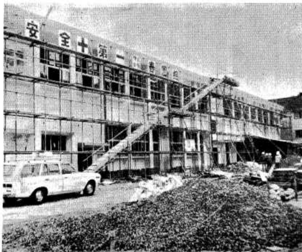
▽ 完成を急ぐ大川中危険校舎改築工事
