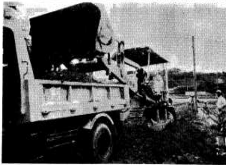
△ 舗装直前の路面地ならし
