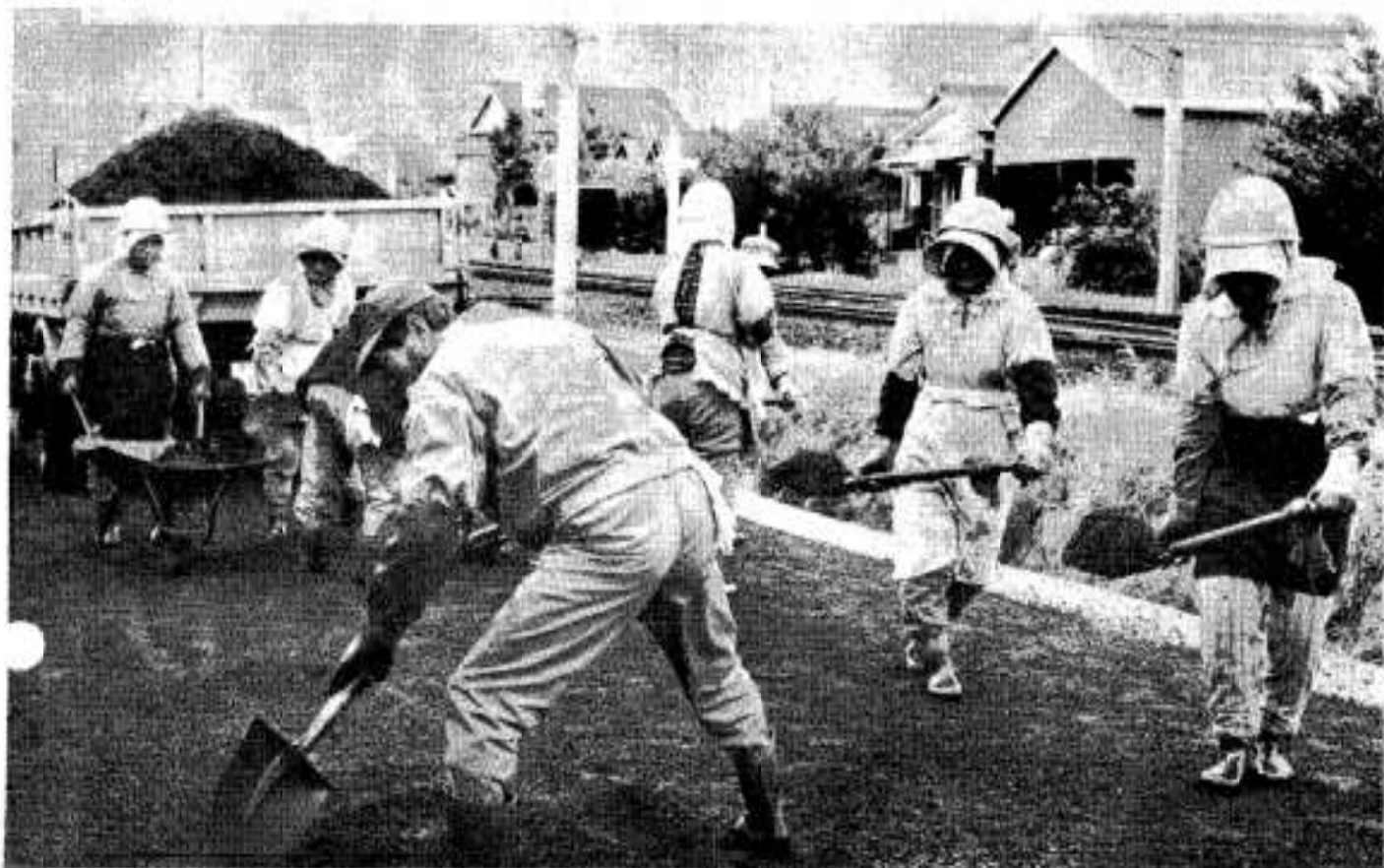
△ 失対による道路の補修工事
