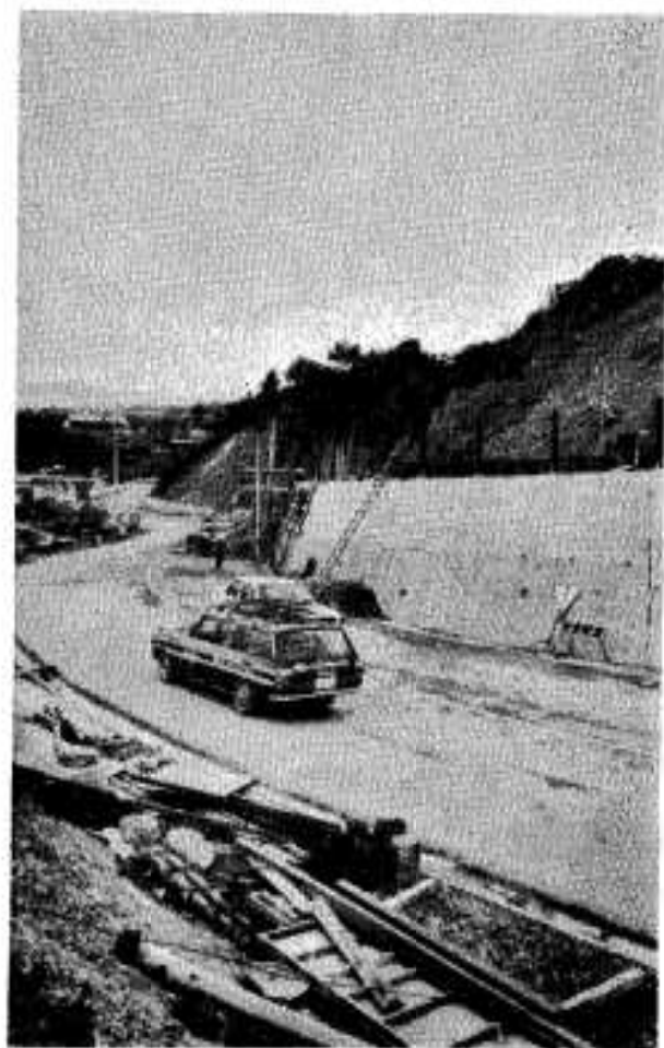
▽ 国民宿舎道路の災害復旧工事急ピッチ
