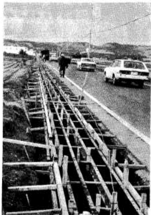
▽ 中津原の排水工事(折日)
