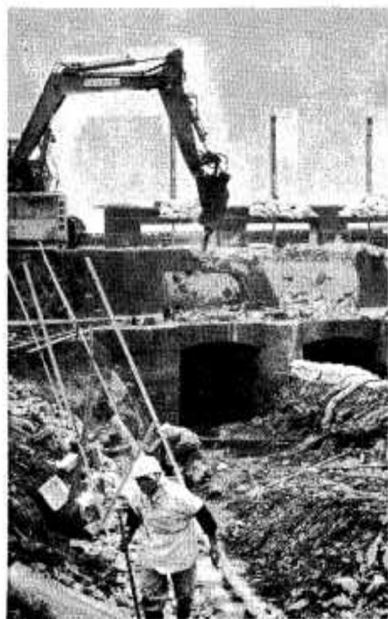
◁ 高潮対策に折多樋門改修工事が急ピッチ
