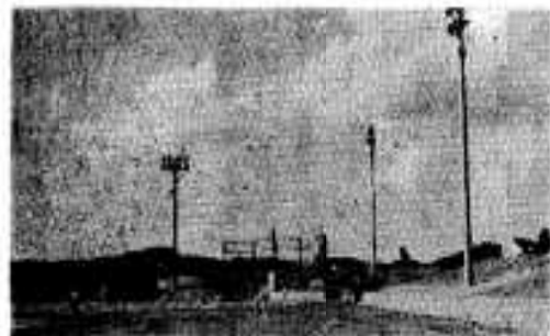
完成になったナイター設備
