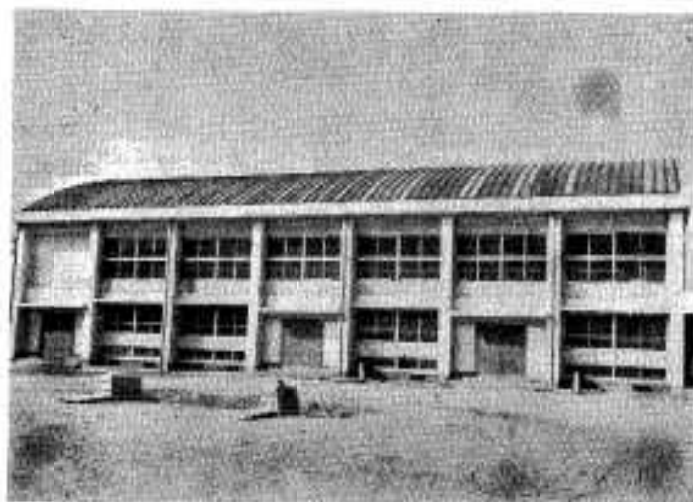
▲ 完成なった脇本小学校屋体 小中学校に体育館9館を建設し児童生徒の体力向上に 尽力した
