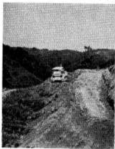
進む圏基団地造成
