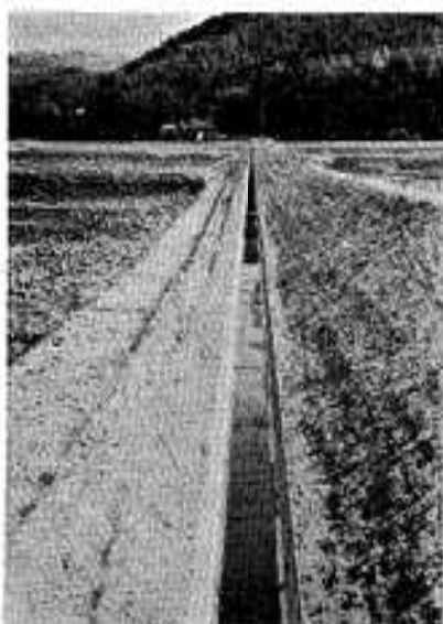
完成した山下地区保場整備
