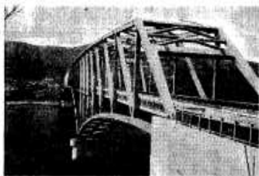
4月9日開通した黒之瀬戸大橋
