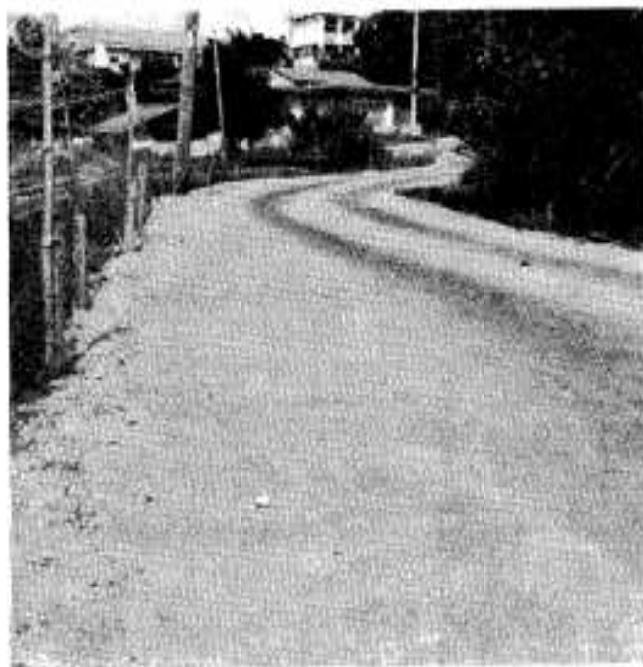
のびる道路舗装工事
