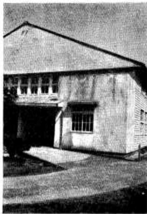
△ 改築される協小屋体
