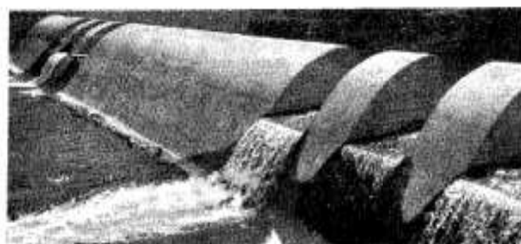
△ 西光いせき(高松川)も完成
