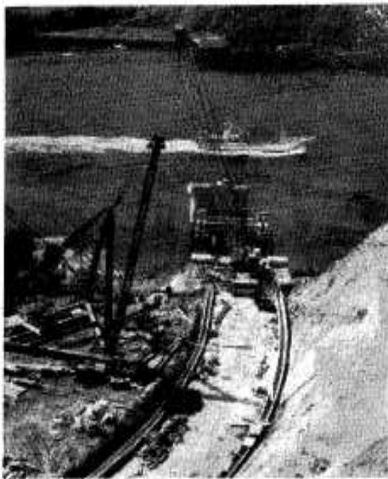
来年3月完成をめざし急ピッチですすめられている黒之瀬戸架橋工事
