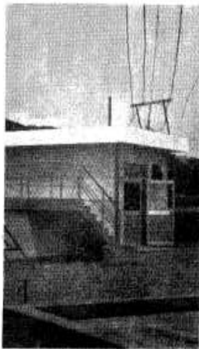
△ 完成したと畜場浄化槽
