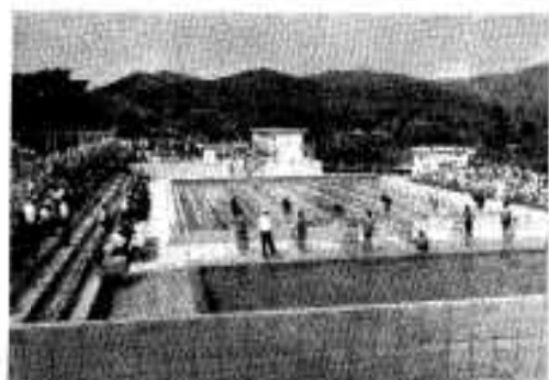
完成した福小プール
