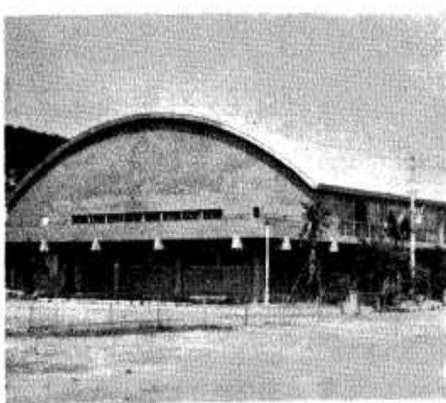
△競技が行なわれる市体育館。本番までには700人収容できるよう急ピッチで拡張工事も進められている
