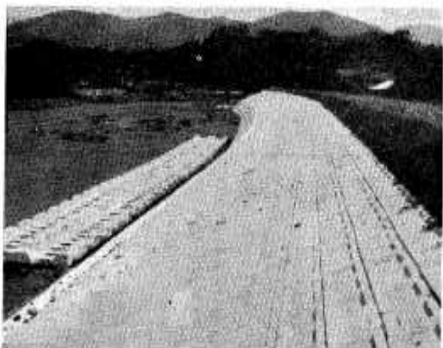
完成した浜田橋上流の右岸堤防
