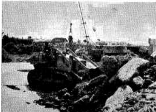
浜田いぜきと浜田橋架け替え工事も急ピッチで進められている。
