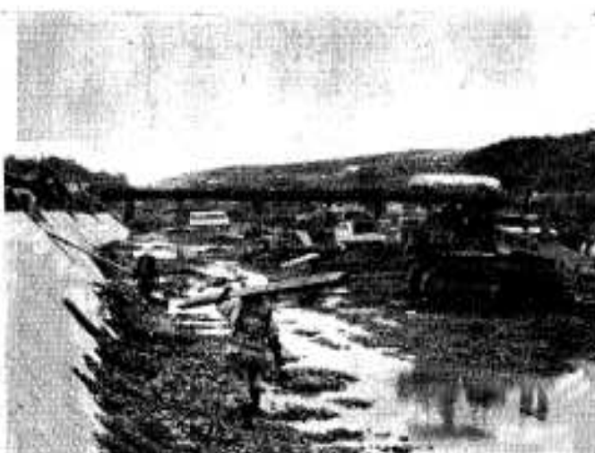
高松川堤防工事と掛け替えられる浜田橋
