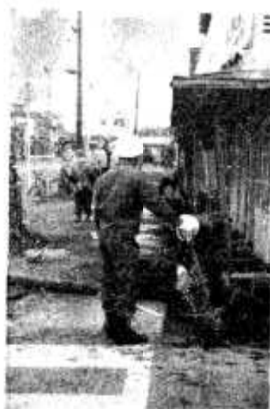
すぐやる係側溝補修(大丸地区)
