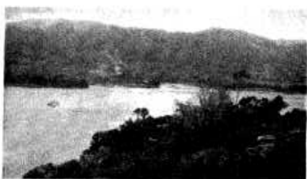
ここに橋がかかる、取り付け道路工事も急ピッチ
