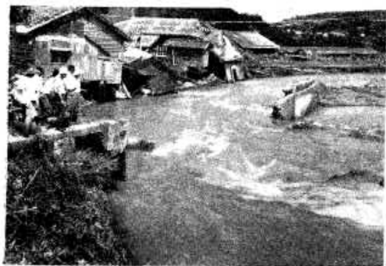
△ 浜田橋の堤防決壊
