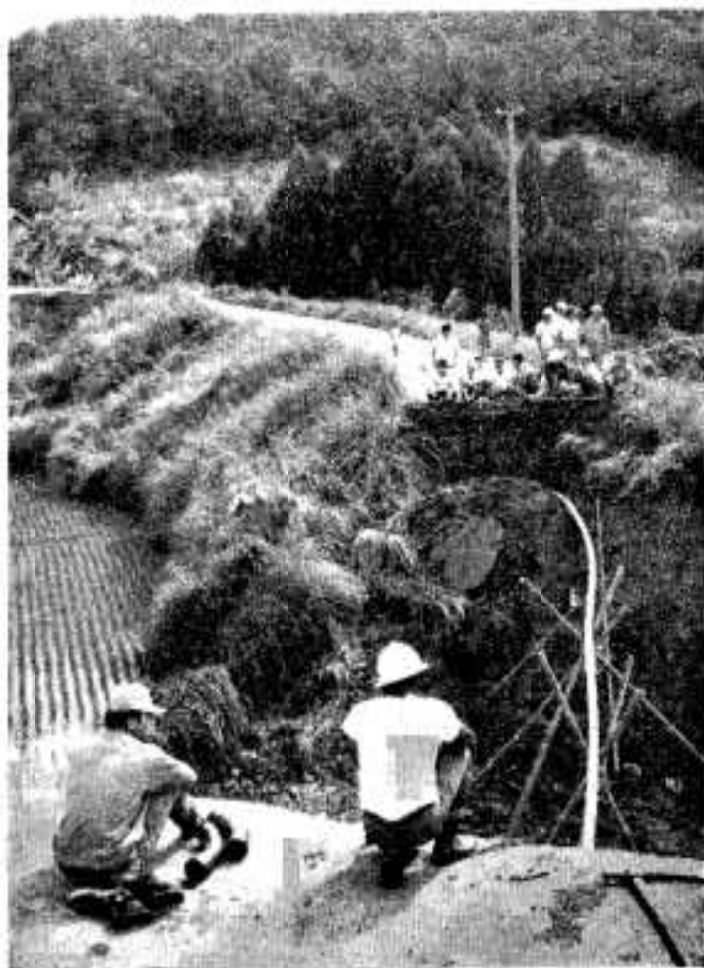
▽市道佐潟線を寸断(柗山住宅入口付近)
