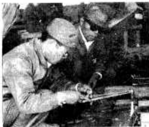
ガス溶接も高度な技術が要求される
