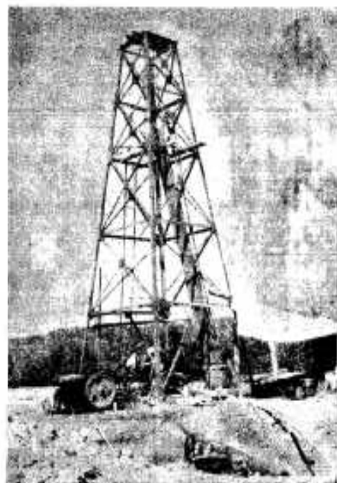
始まった温泉掘削ボーリング
