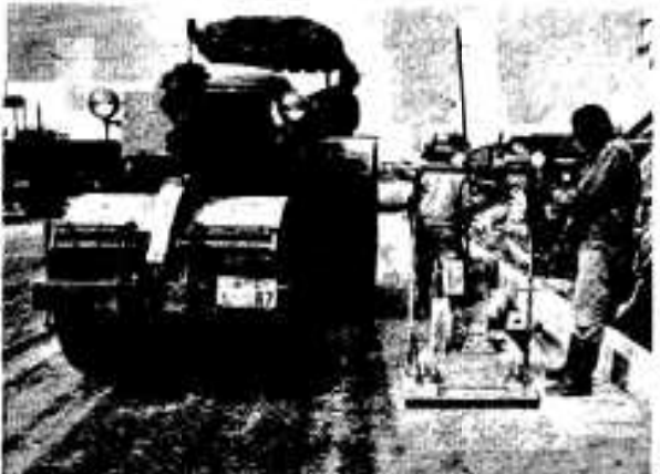
道路舗装も急ピッチ
