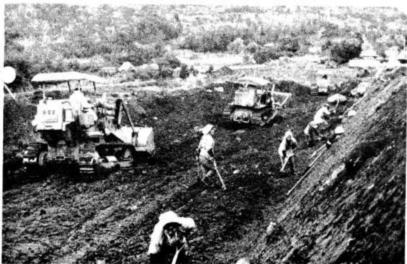
▲黒之瀬戸大橋取り付け道路工事も急ピッチ
