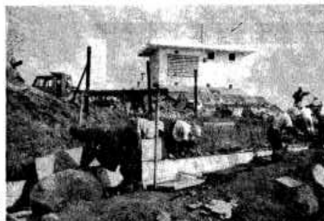
貯水池整備も急ピッチ
