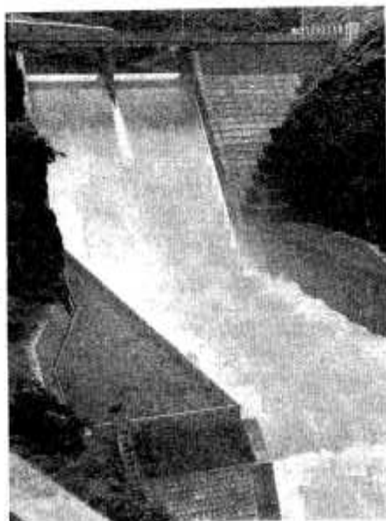
しかしこの豪雨で偉力を発揮したのは、3月完成したばかりの高松防災ダムだった。下流200%の美田は冠水をまぬかれた。
