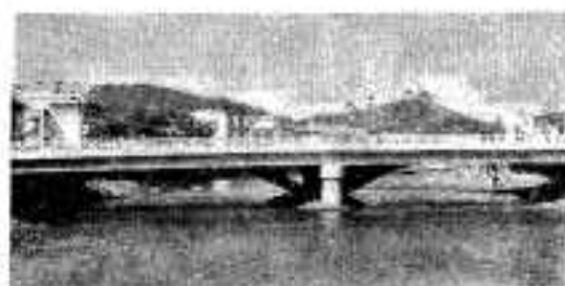
(完成後の高松橋)
