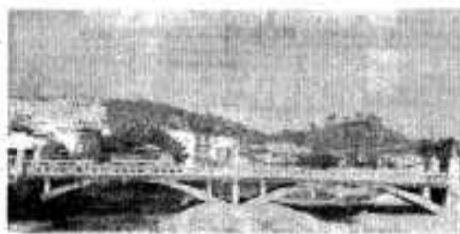
(もとの高松橋)
