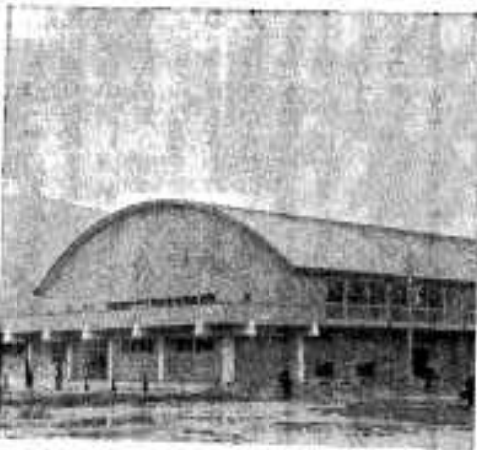
完成した総合体育館
