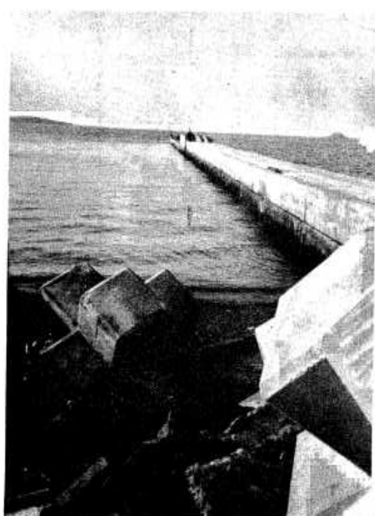
新港建設も着々と進んでいます。
