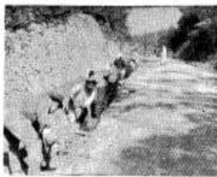
(羽田附近の本管布設工事)
