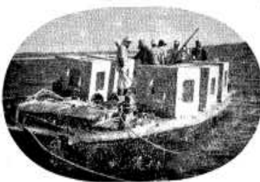
ブロックを投入して魚の巣づくり↓
