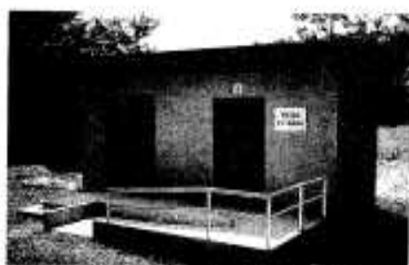
車イス専用トイレも設置
