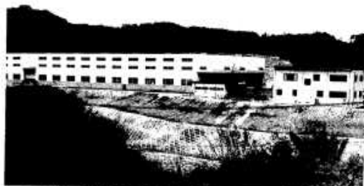
完成した鹿児島金属(株)阿久根工場(市内山下)
