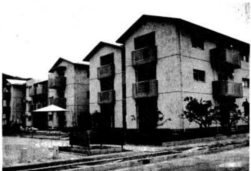
市営住宅「鶴見タウン」B・C棟が完成。4月から入居が始まりました。
