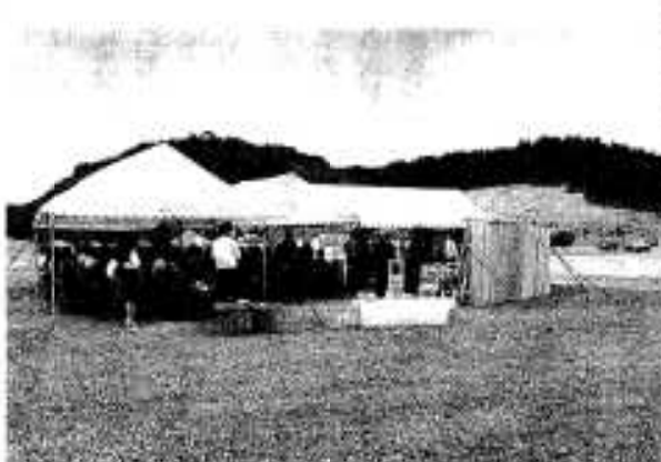
工場建設用地で行われた起工式
