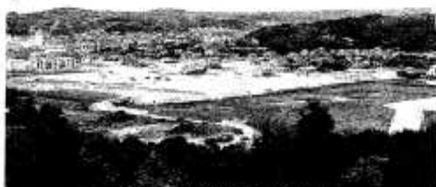
着々と造成が進む潟地区
